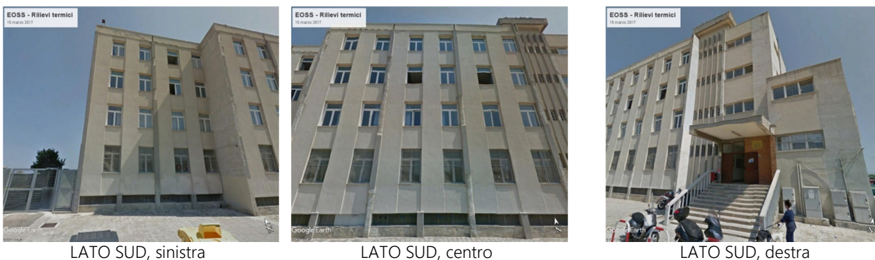
Figura 1. Edificio “Ripartizione Personale”
